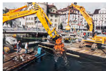
Spektakulärer Rückbau der Seebrücke Luzern mit dem eigens konstruierten Boot «Fränzi» für den Muldenabtransport.
