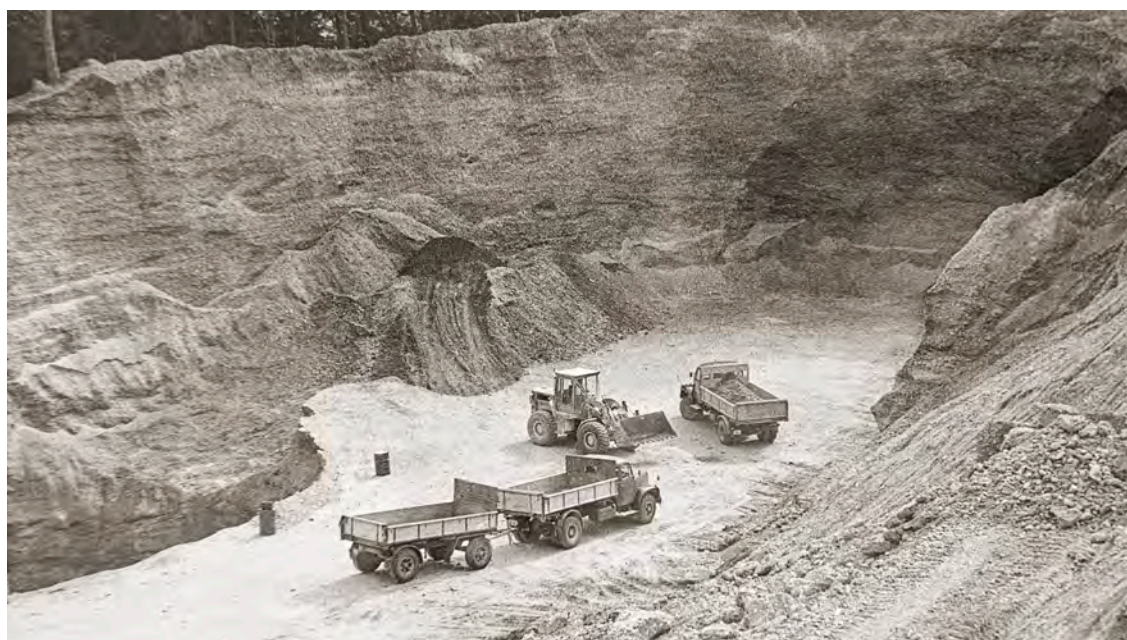
Kiesabbau in der Kiesgrube der Kigro AG in Gettnau.
