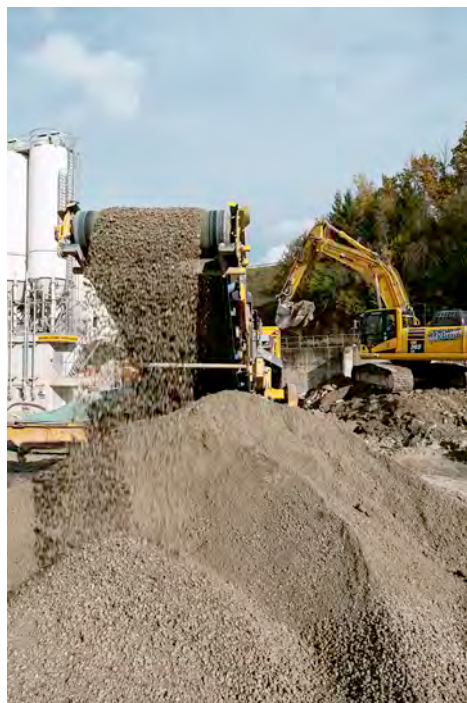
Aufbereitung Betongranulat bei der Kigro AG in Grosswangen.
