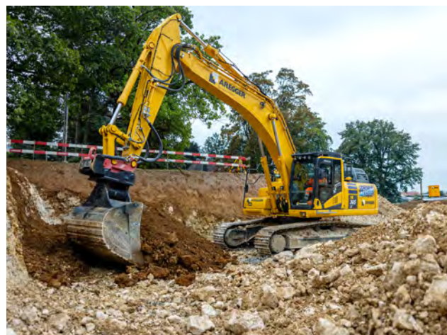
Ein Hybridbagger HB 365 bei Erdarbeiten.
