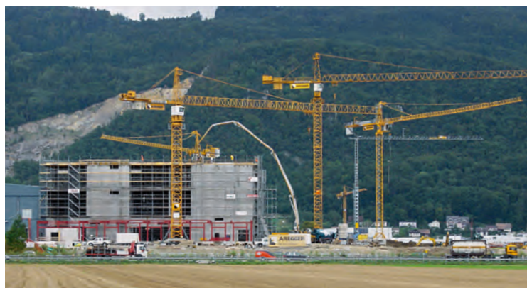
Mehrere Aregger-Kräne auf der Grossbaustelle beim Migros-Verteilzentrum in Neuendorf/SO.
