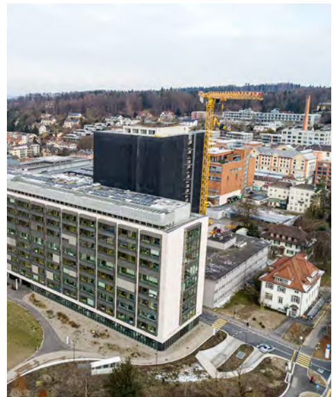
Rückbau Spital Winterthur.
