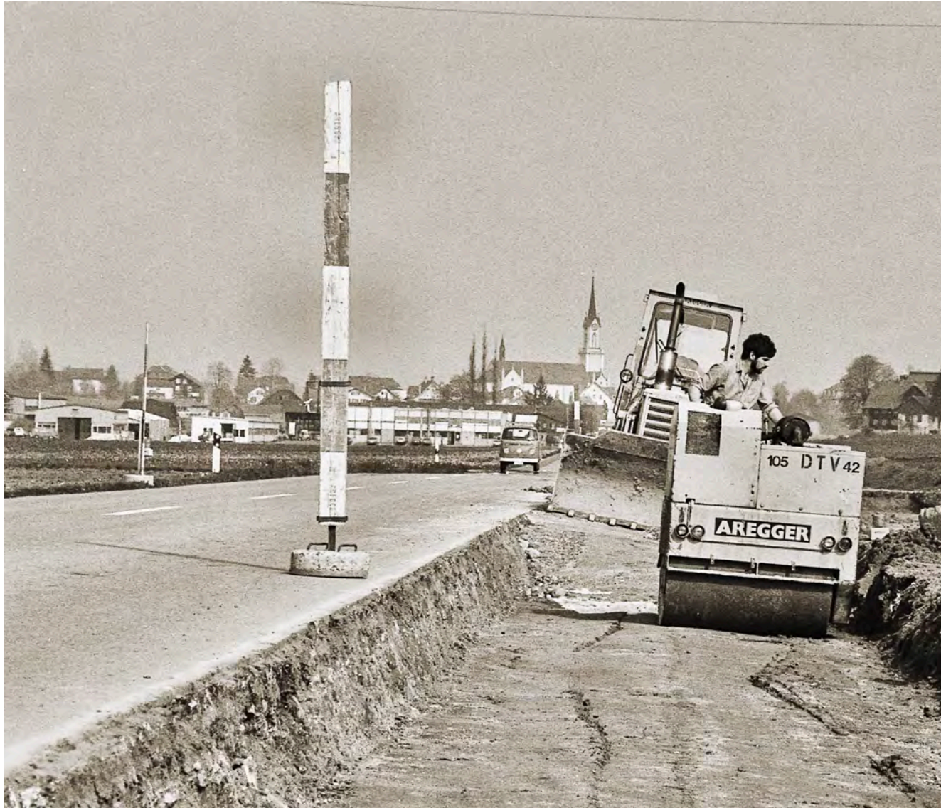
Ohne Baustellenabschränkung und Helm: Polier Josef Stocker bei Tiefbauarbeiten in Grosswangen.
