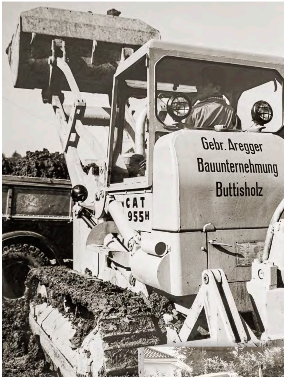
Aushubarbeiten mit dem Cat 955, der ersten grossen Baumaschine.
