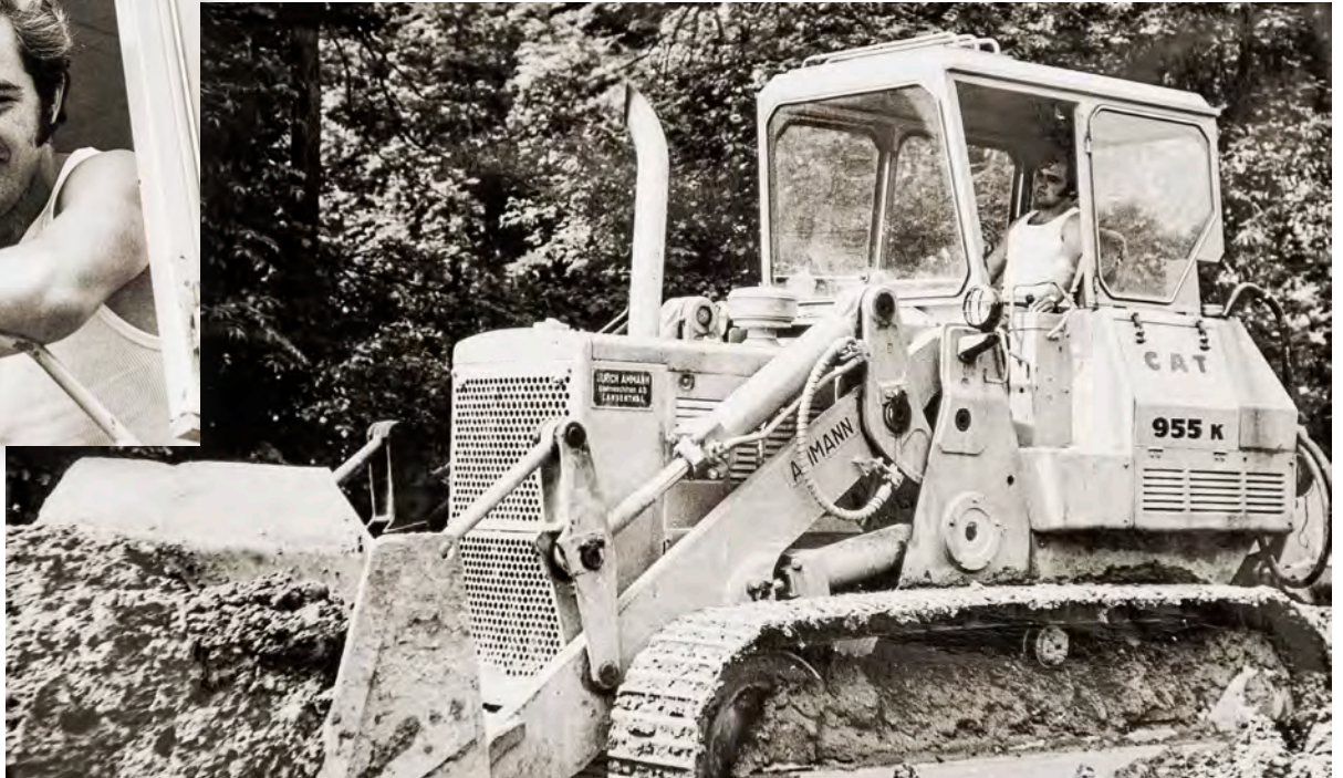
Walter Bieri, hier noch als Traxführer, später Tiefbaupolier.
