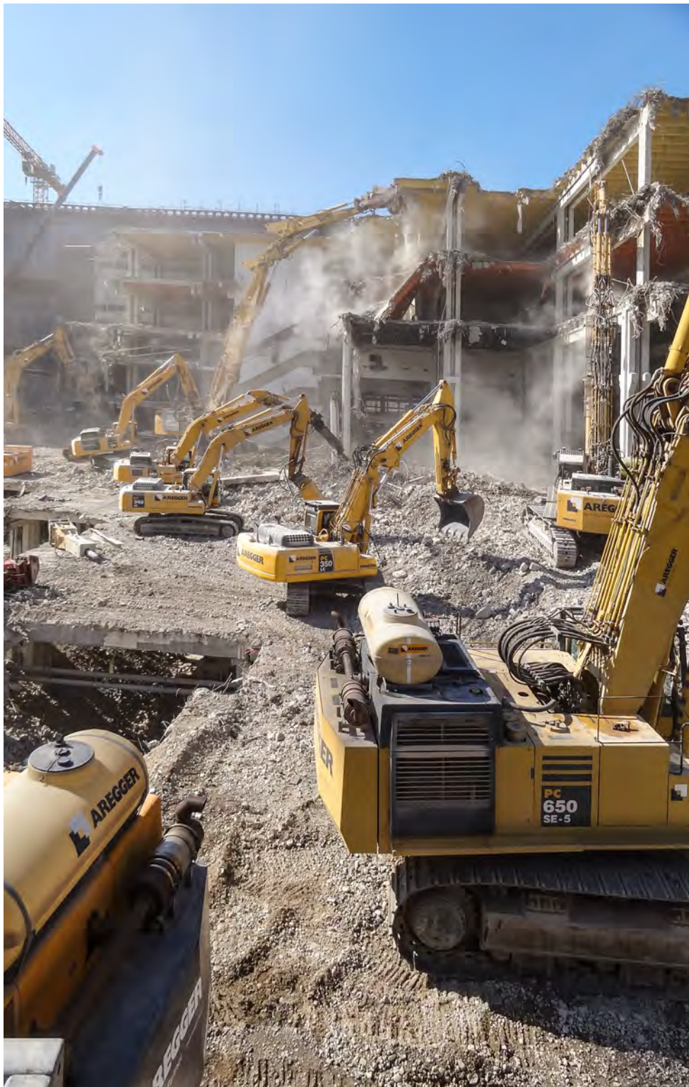
Rückbau Messe Basel 2012.
